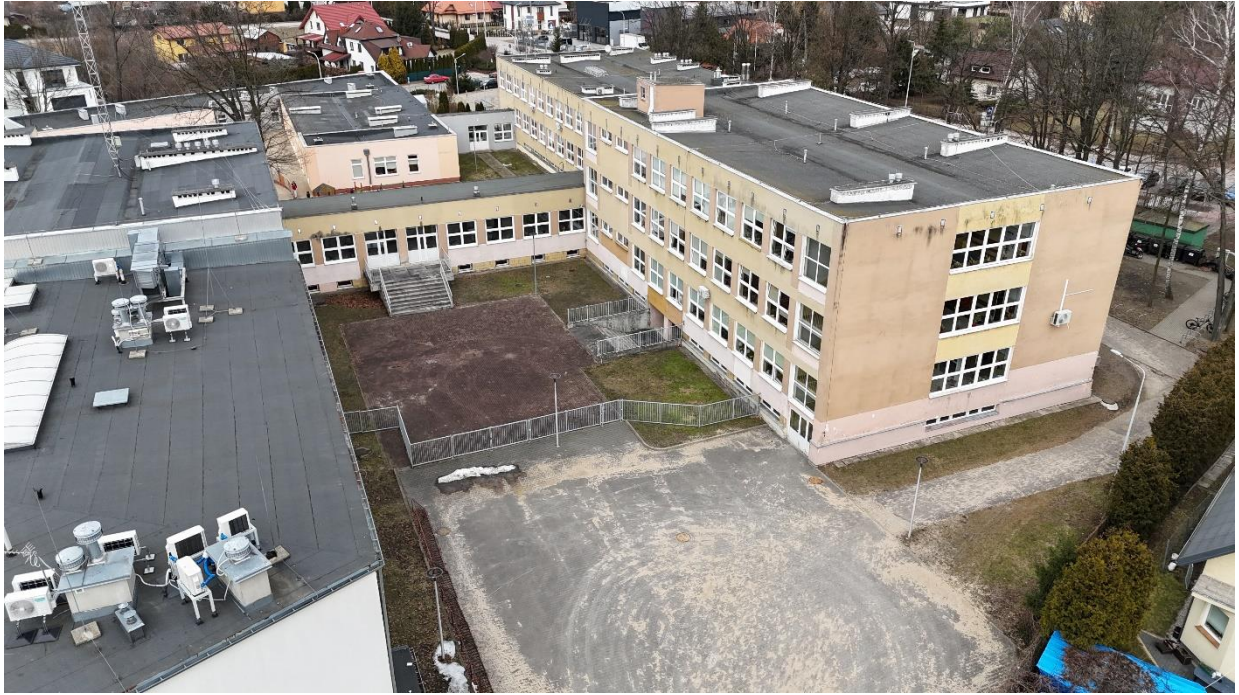
Widok na szkołę przed termomodernizacją
