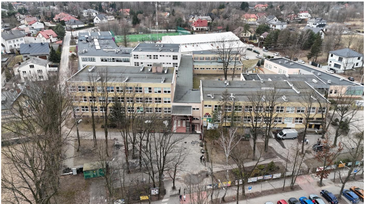
Widok na szkołę przed termomodernizacją
